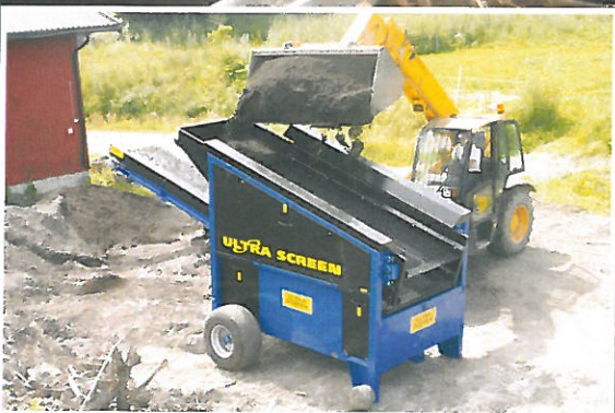
Dépistage du sol à 15mm au taux de 45 tonnes par heure
